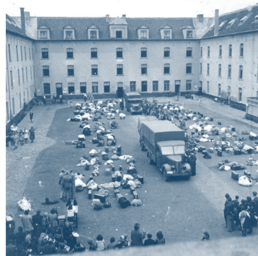
↑ Arrivée de prisonniers dans la cour intérieure de la caserne Dossin, 1942.
